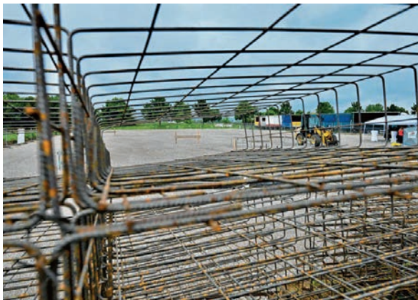
Noch sind erst die Bagger angefahren: Auf diesem Areal an der Gersthofener Henleinstraße entsteht die Deutschlandzentrale des weltweit agierenden Lagerlifte-Herstellers Modula. Foto: Andreas Lode
